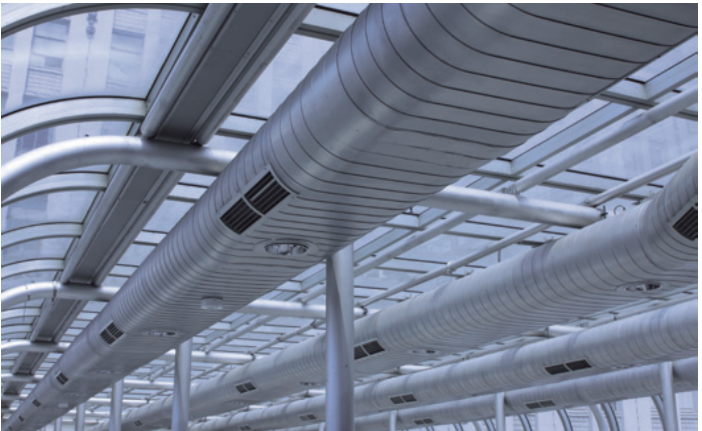
R-717 – gebruikt in grote airconditioningsystemen (chillers).
